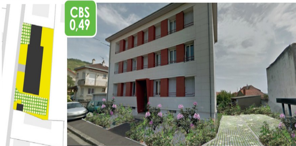
TEST 2 : TRAITEMENT DES EXTÉRIEURS UNIQUEMENT
