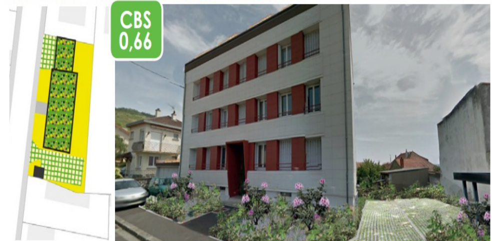
TEST 4 : AVEC TOITURE TOTALEMENT VÉGÉTALISÉE
